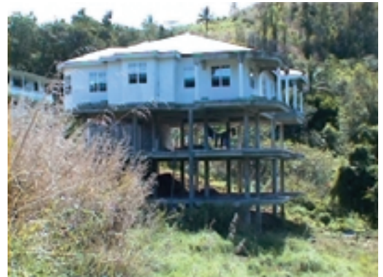
Dans un tel cas, on pourrait parler de construction garantie « pro-sismique » !...
